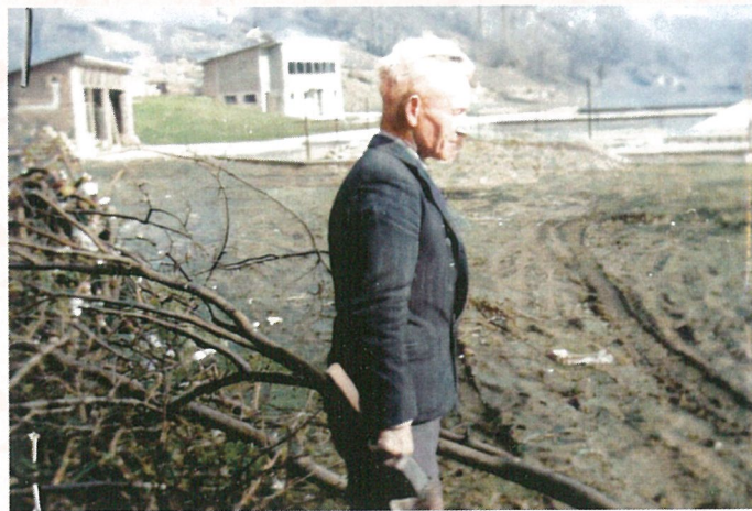
Ještě jeden snímek ze stavby koupaliště
