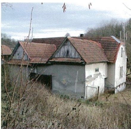
Pohled od jihu
