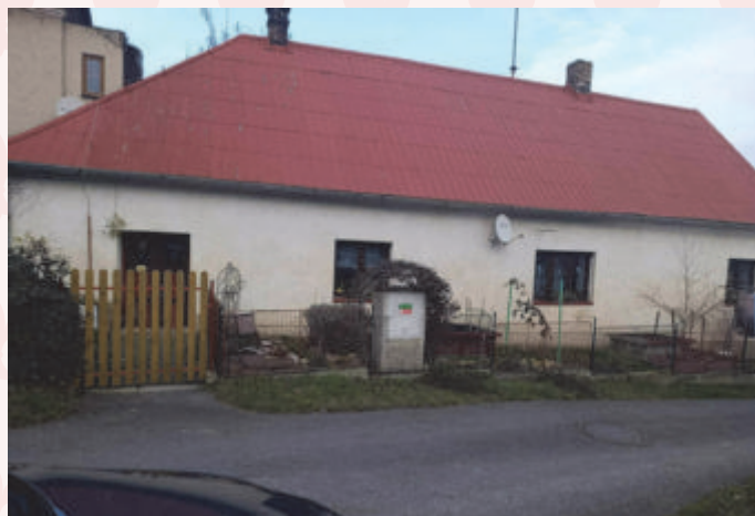
současný stav čp. 302
