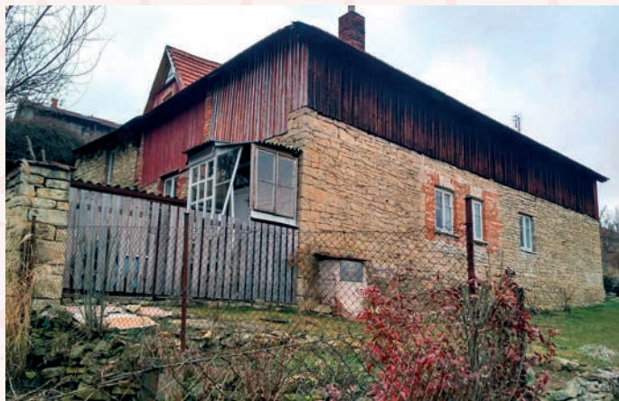
současný stav, pohled od západu
