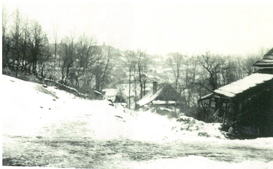
Čp. 196 od jihu před přestavbou
