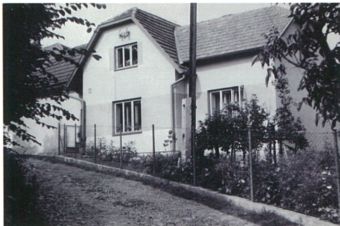
Současný stav čp. 180
