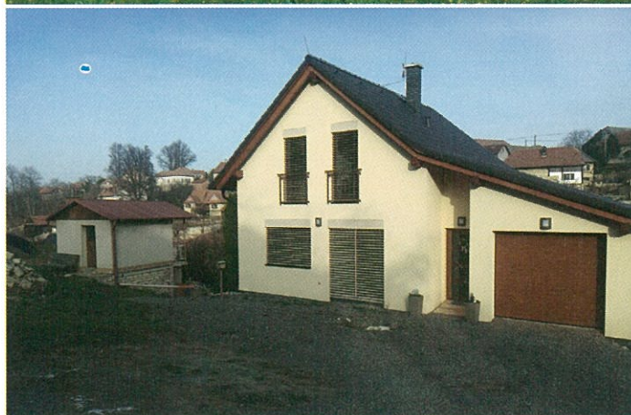
po demolici chalupy nový RD č.p. 699
